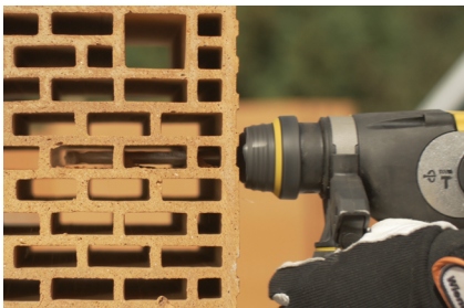
1 Сверління отвору в без ударному режимі
